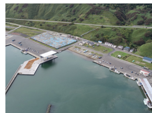
＜港湾・漁港工事＞
